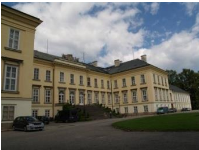
Současný stav – pohled na podestu, původně zimní zahradu
